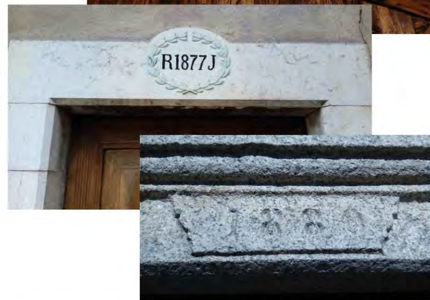
Encadrements de portes datés en molasse (1830), calcaire (1877) et granite (1880).
